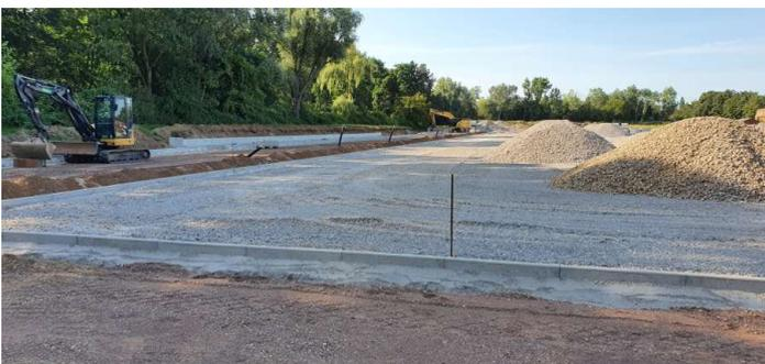
Die Tragschicht soll für die Stabilität des Belagssystems, bleibende Ebenheit auch bei Belastung und für die Wasserabführung sorgen. Mineralische Tragschichten müssen insbesondere frostunempfindlich ausgelegt sein.
