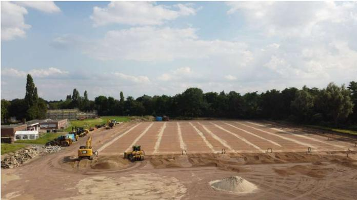
Dann wurde die Tragschicht aufgetragen, die aus verschiedenen großen Körnern Mineralbeton besteht.
